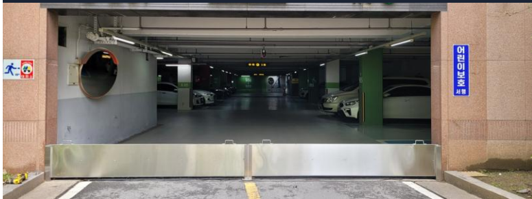
설치 후, 차수판(물막이판)
