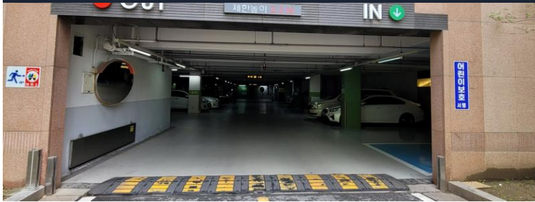
설치 전, 아파트 지하주차장 입구
